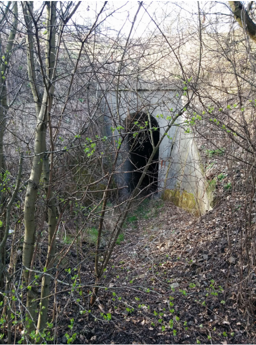
stávající propustek pod tratí
