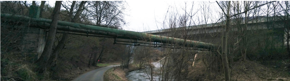
situace/ lávka u viaduktu
