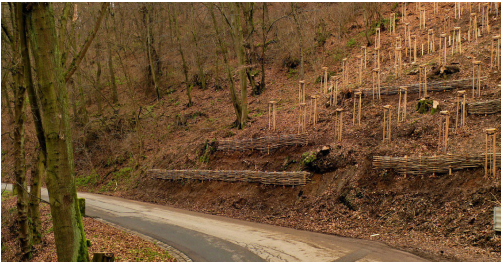
inspirace/ prutěné zpevnění svahu
