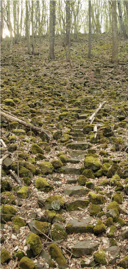
fotografie/ současný stav
