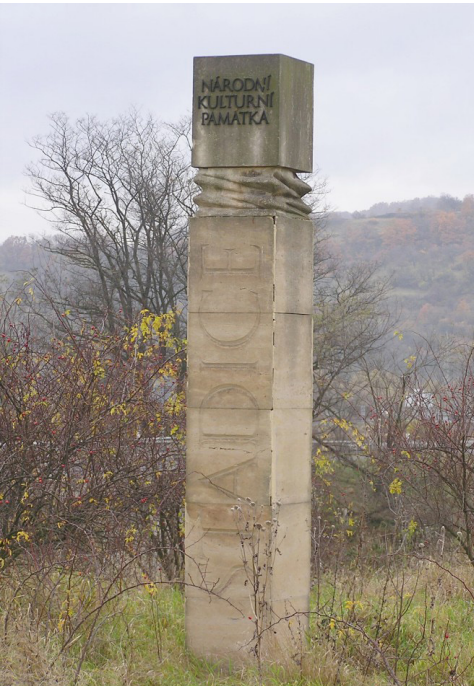
fotografie/ současný stav - stadický sloup
